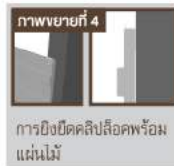
ติดตั้งคลิปล็อคให้ได้ระดับตามที่กำหนดไว้ และให้อยู่ที่กึ่งกลางของโครงคร่าวเหล็ก
