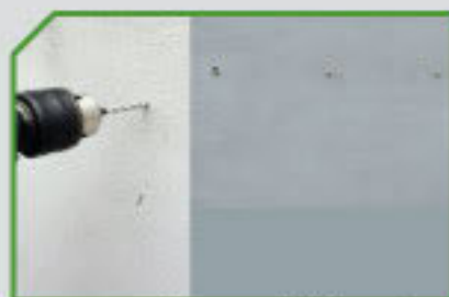
2. เจาะรูตามจุดที่กำหนด 3 จุด โดยใช้ดอกสว่าน ขนาด 5 มม.
