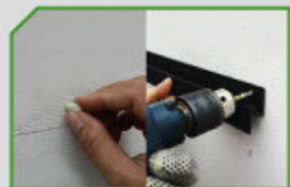
3. สอดพุกและขันสปริงติดตั้ง Hanging Bar
