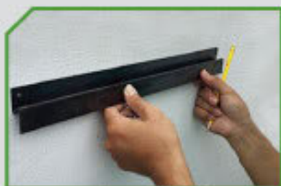
1. กำหนดระดับที่ต้องการติดตั้ง โดยใช้ Hanging Bar วัดตามและมาร์คจุด
